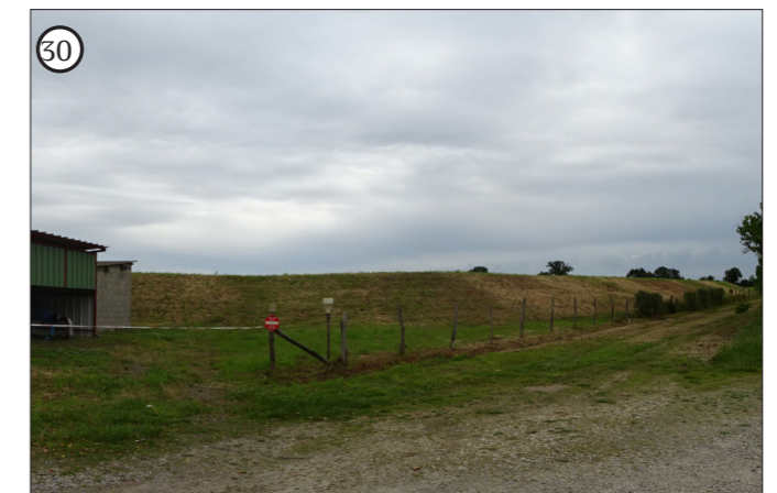
30 Bassin de retenu d'eau
